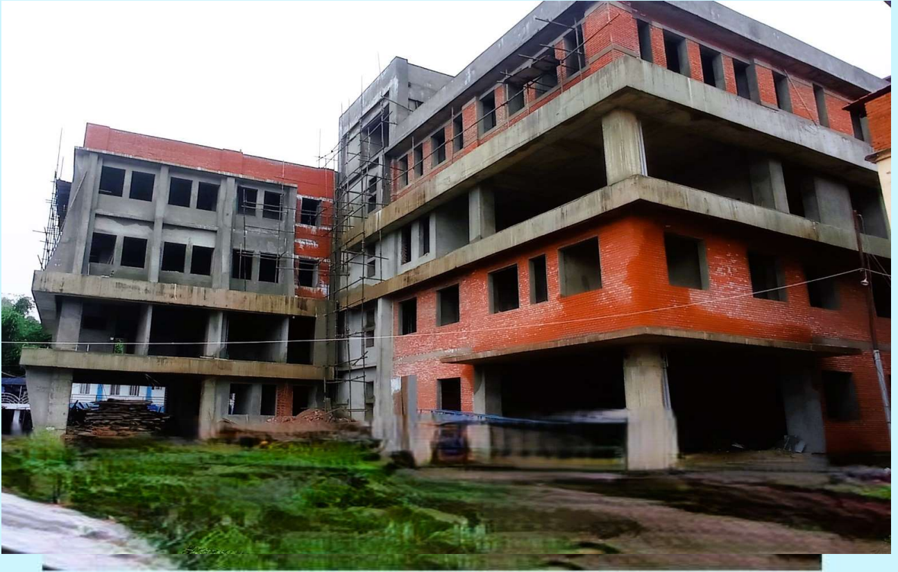
निर्माण हुदै गरेको नयाँ भवन
