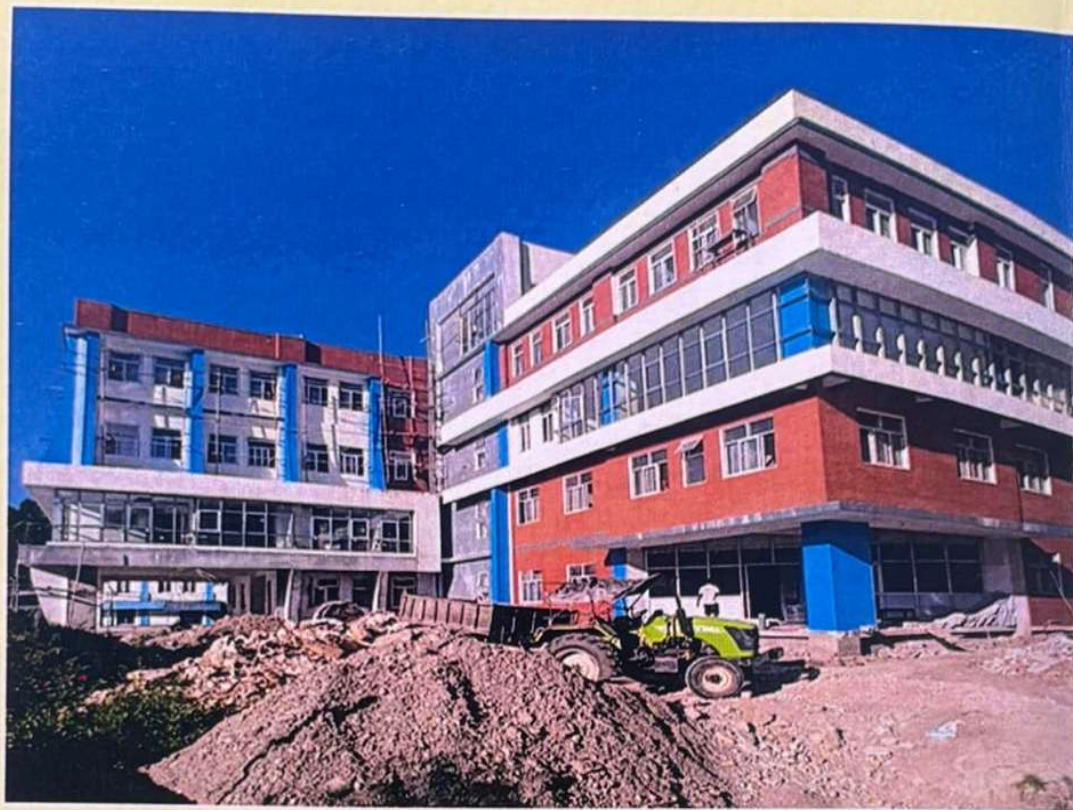
निर्माण हुँदै गरेको नयाँ भवन
